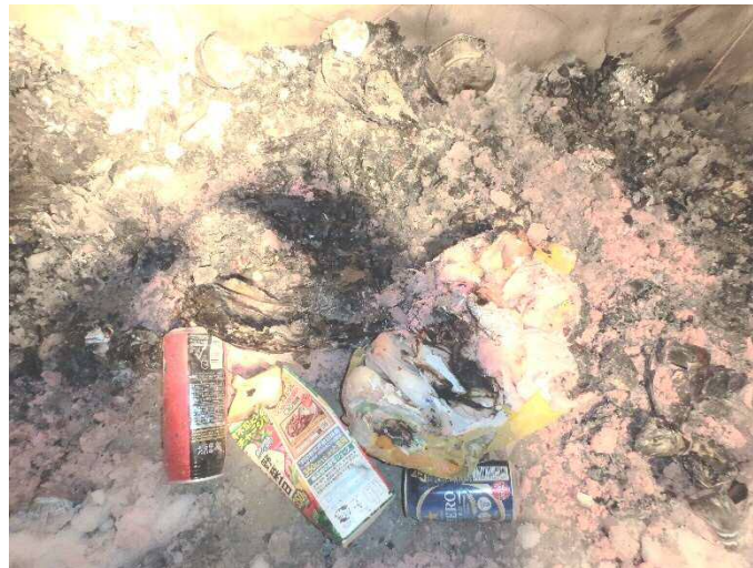
ゴミ集積場内のゴミが燃え、消火器により初期消火した
